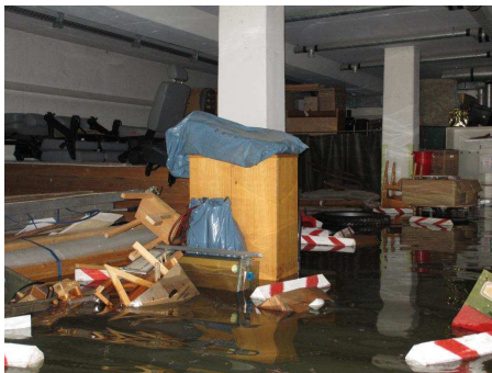
„Land unter“ im Keller der Malteser Niederaichbach
