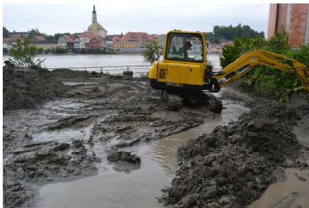
Der zerstörte Freizeitbereich der Schule
